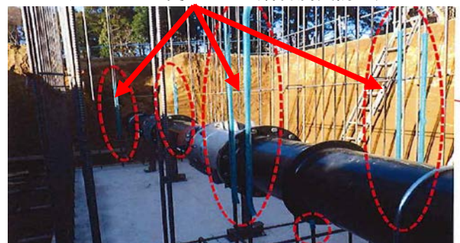
【鋼管配管時の鉄筋養生状況】 (ホースでの養生による鋼管腐食防止)
