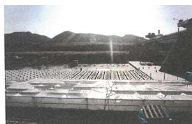
【養生屋根設置状況】 【テータカーによる温度管理】
