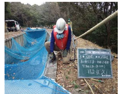
【曲線部のレジコン蓋設置状況】
