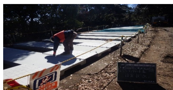
【曲線部のレジコン蓋設置状況】
