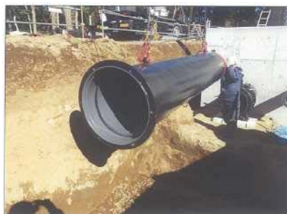
【鋼管配管時の鉄筋養生状況】 (ホースでの養生による鋼管腐食防止)
