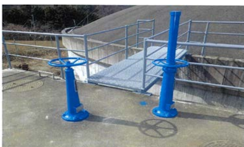
【既設手摺り及び開閉機塗装状況】
