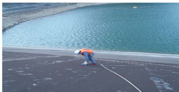
写真 作業状況
