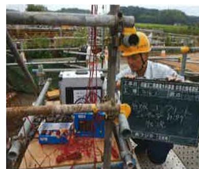
【コンクリート充填検知状況】
