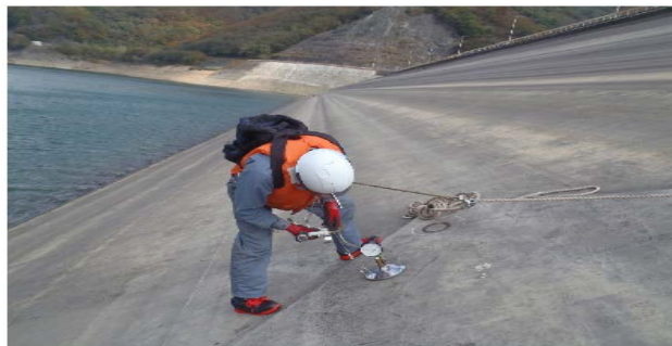
写真 作業状況
