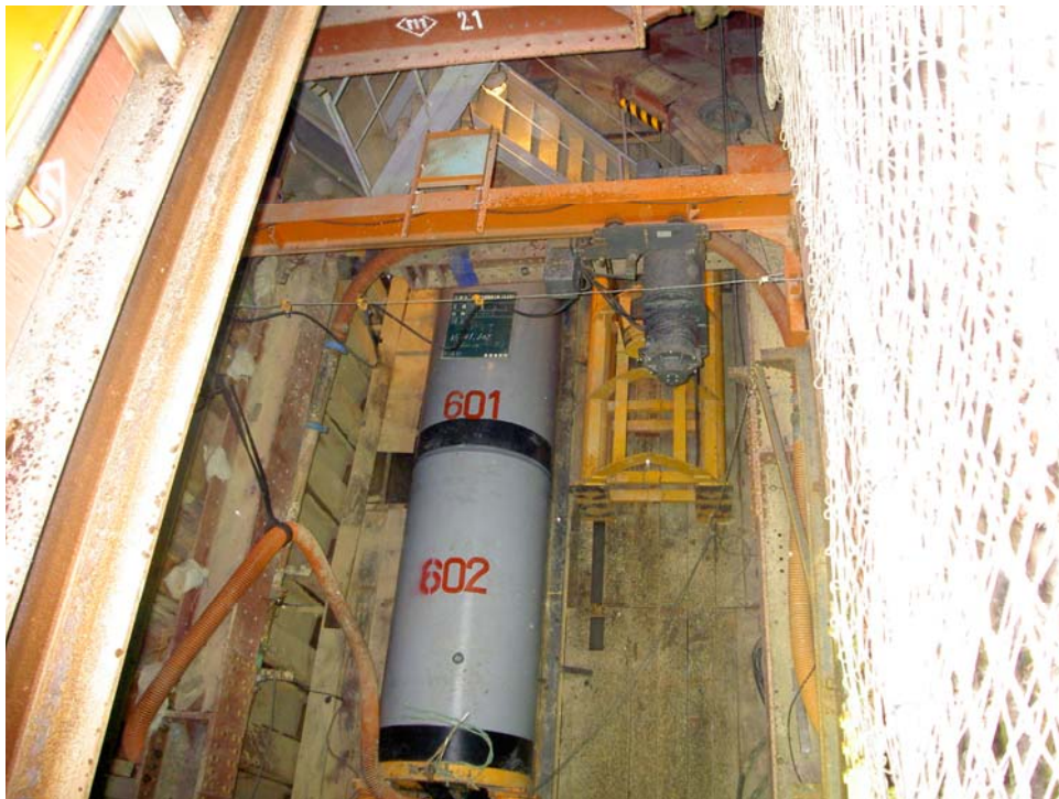
2管推進用発進立坑・推進中
